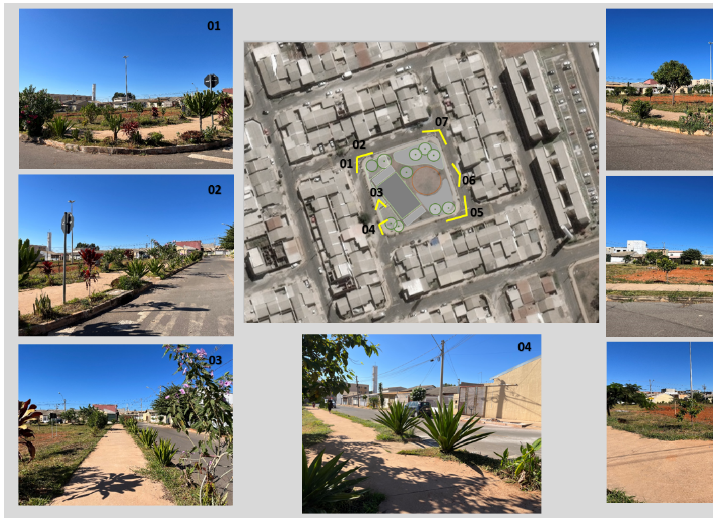
Figura 05. Situação Atual da Praça QN 29 do Riacho Fundo II. Fonte. Vistoria técnica/ DISUL em 19/06/2023 .
