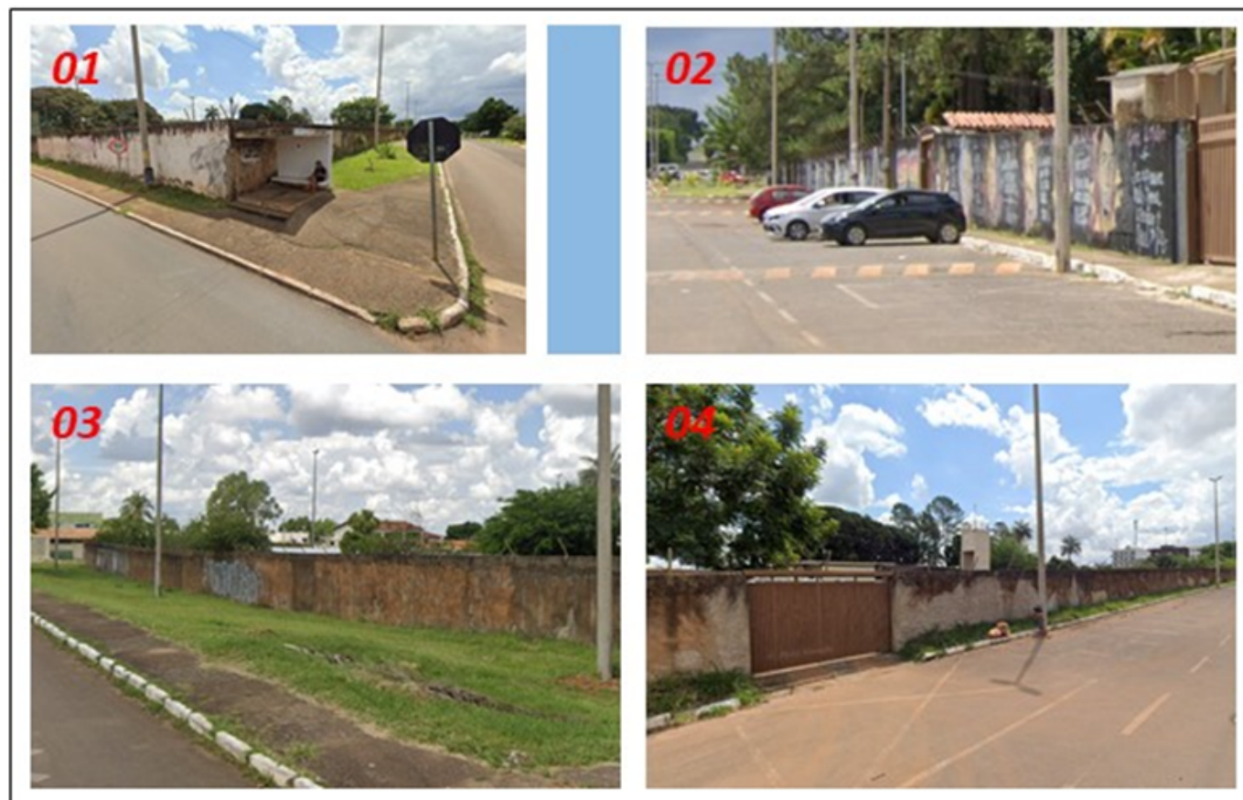
Figura 09: Foto 01: parada de ônibus; Foto 02: estacionamento regular; Foto 03: falta arborização; Foto 04: acesso de veículos ao EC 08. Fonte: SUDEC/DISUL
