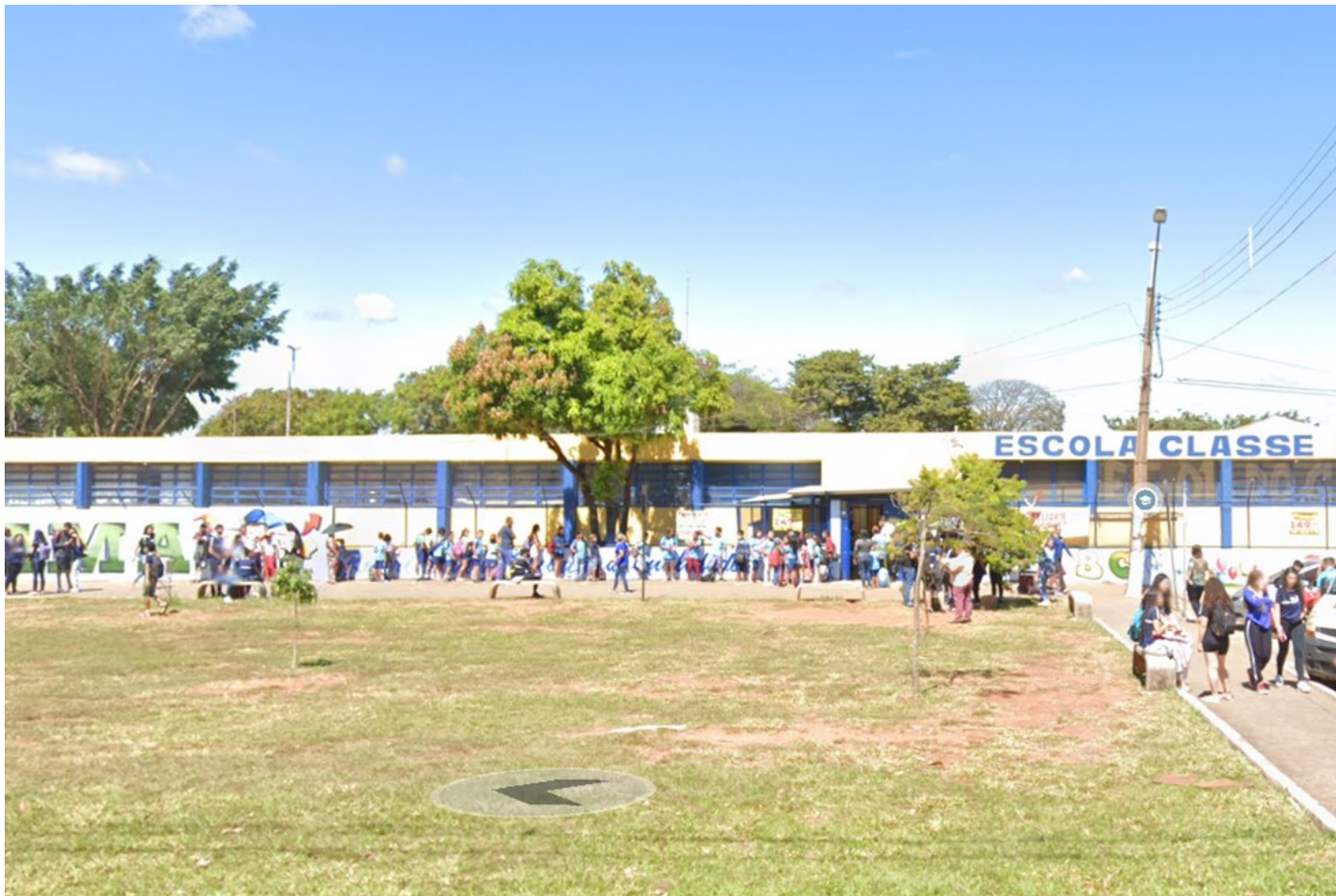
Figura 24. Referência possível de fachada para a EC03 do Gama. Fonte: Google Street View
