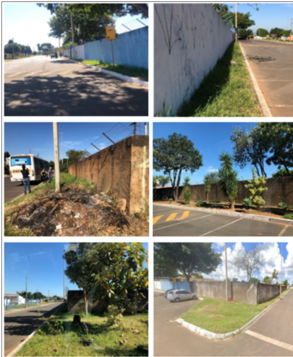
Figura 10: Ausência de calçadas na área limítrofe ao Lote AE, Quadra 10, Jardim de Infância, Setor Sul, Gama, (vista frontal, lateral direita e posterior).
