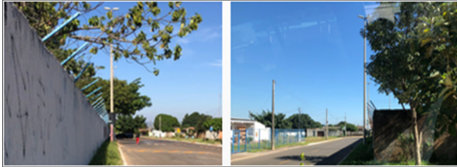
Figura 12: Iluminação pública na área limítrofe ao Lote AE, Quadra 10, Jardim de Infância, Setor Sul, Gama.
