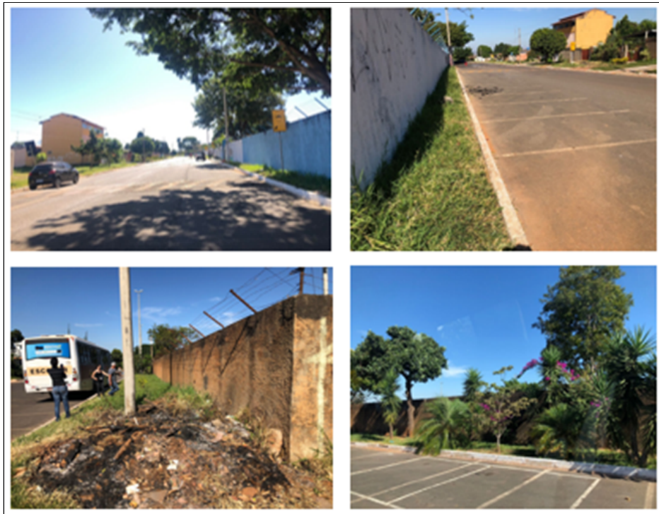
Figura 9: Estacionamento implantado na área pública circunvizinha ao Lote AE, Quadra 10, Setor Sul, Gama (vista frontal e posterior).
