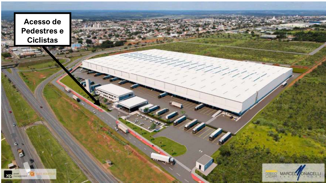
Figura 52 – Acesso de Pedestres e Ciclistas ao empreendimento. Fonte: Imagens 3D produzidas por Marcelo Monacelli Arquitetura.
