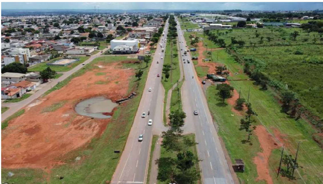
Figura 203 – Ciclovia ao longo do canterio central da DF-290.
