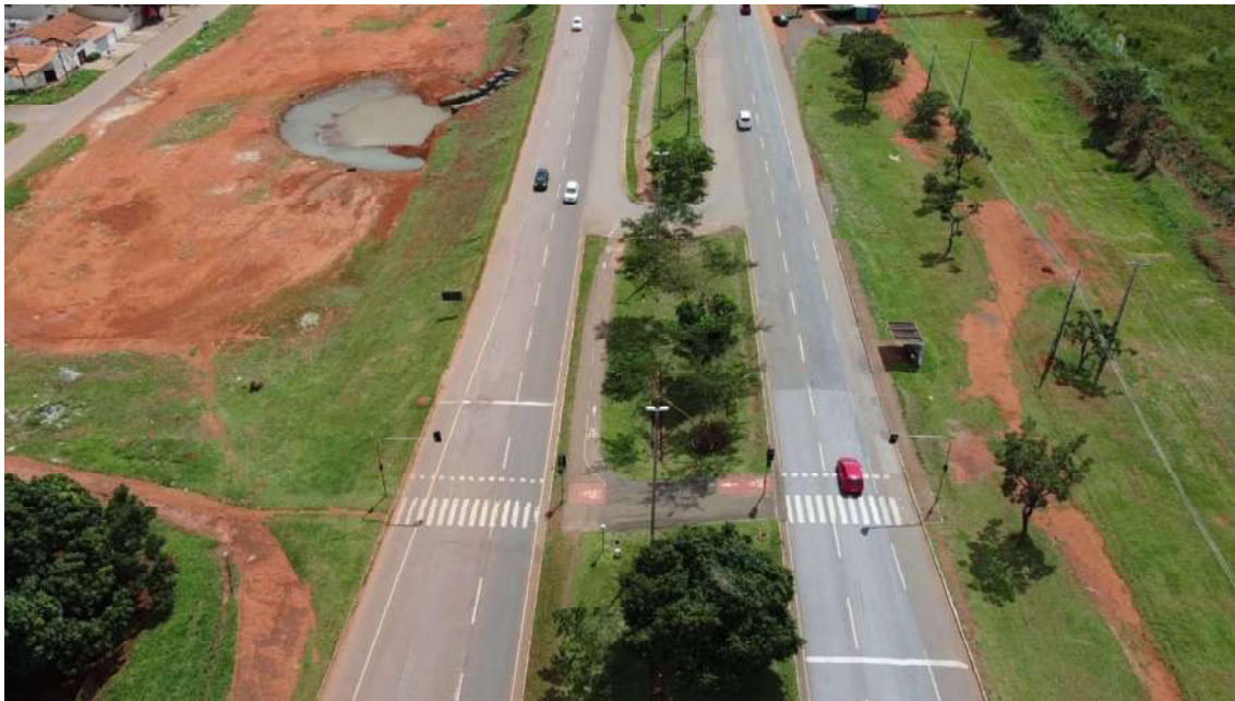
Figura 202 – Pequeno trecho de calçada em frente ao ponto de ônibus e ciclovia no canteiro central da DF-290.
