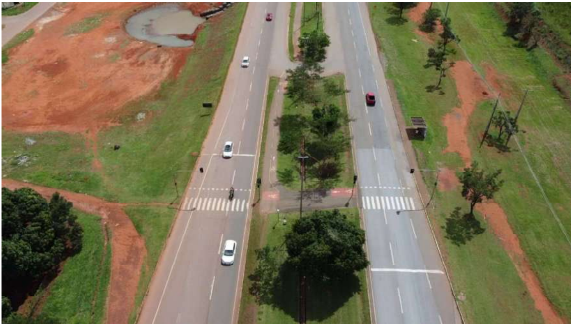
Figura 211 – Travessias semaforizadas na DF-290 e parada com abrigo em apenas um dos sentidos da via.
