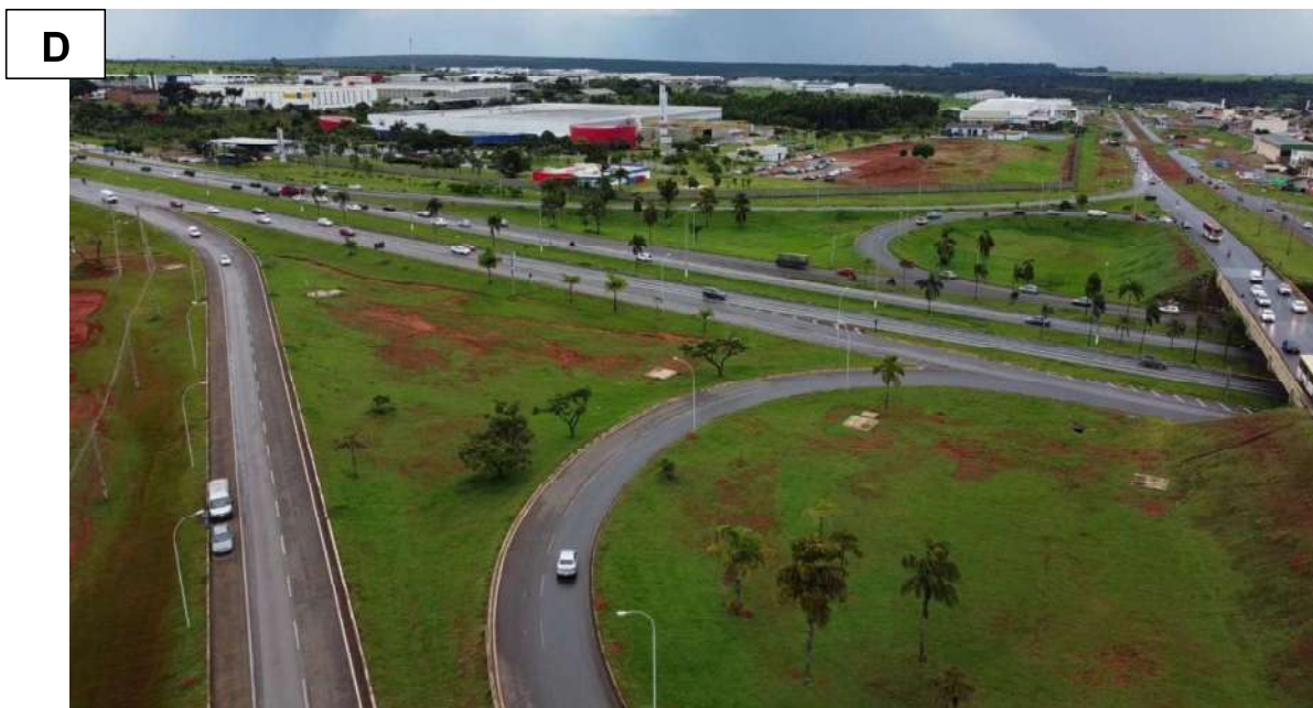
Figura 209 – Ilustração da alça do viaduto.
