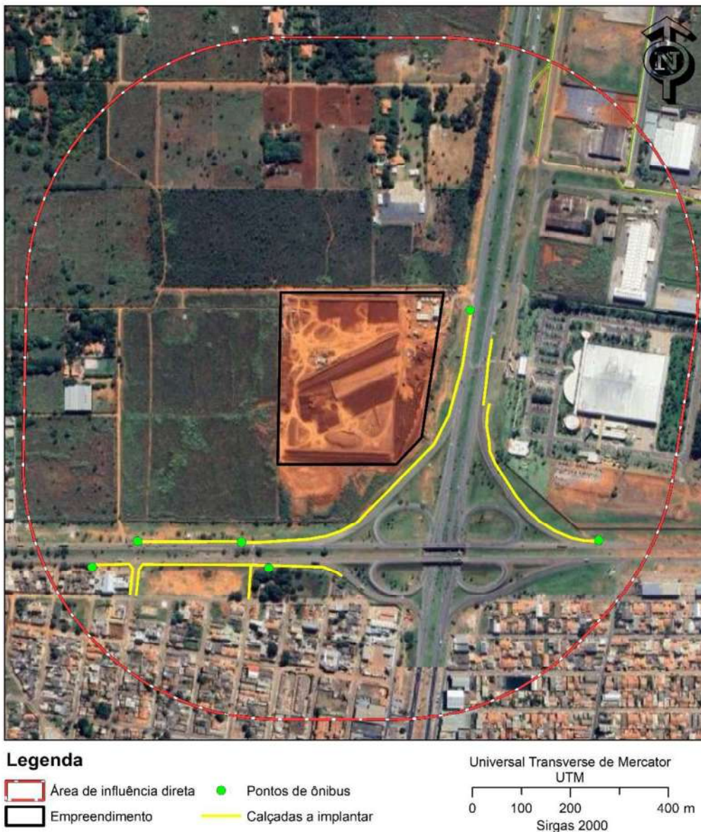
Figura 210 – Trechos na AID que carecem de infraestrutura de calçada e acessibilidade.
