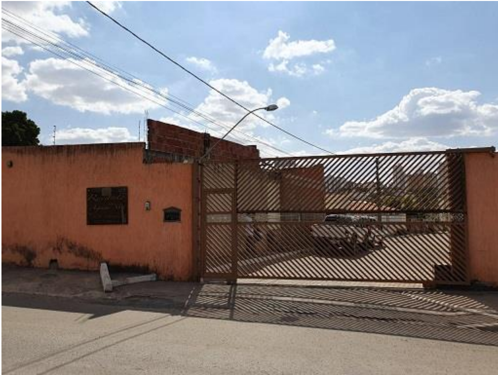
Figura 10 - Portão s/ guarita
