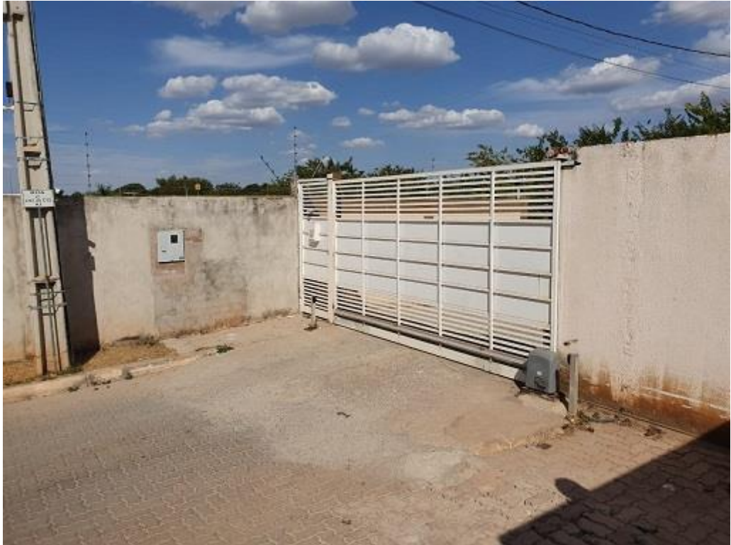
Figura 18 - Portão s/ guarita (visão interna)
