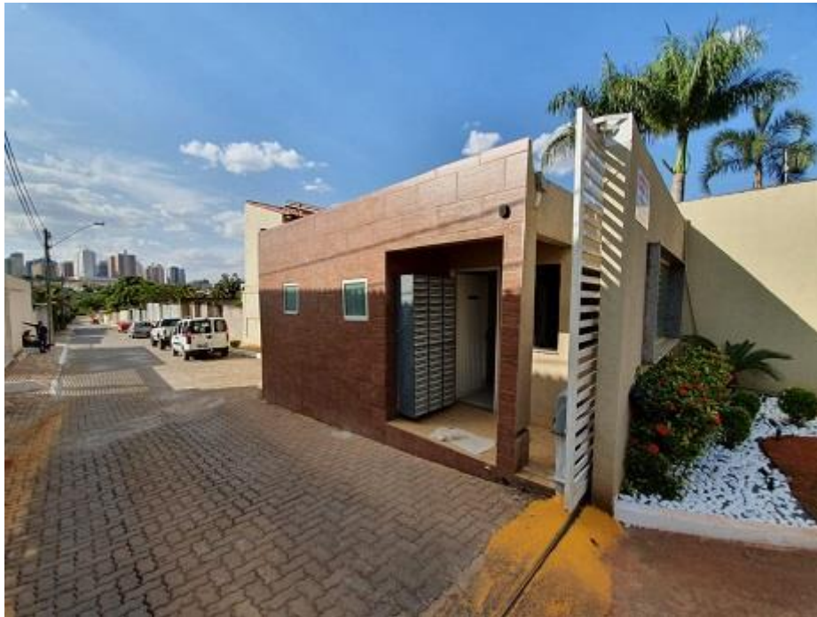
Figura 22 - Entrada principal com guarita
