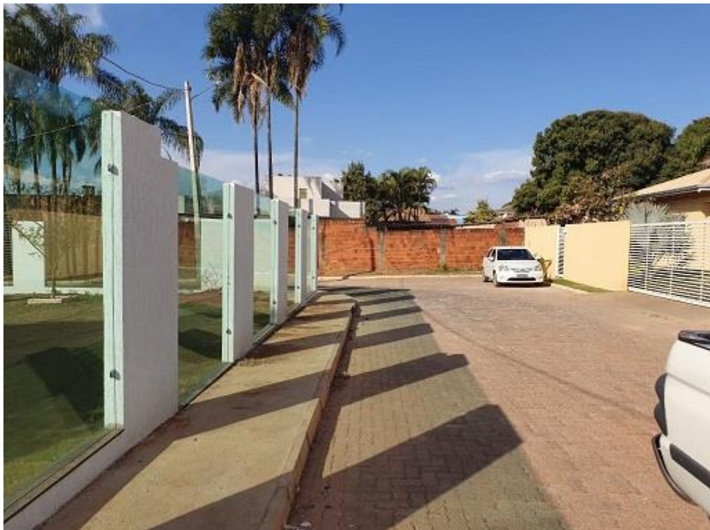
Figura 3 - Muro lateral confronta-se com limite do lote
