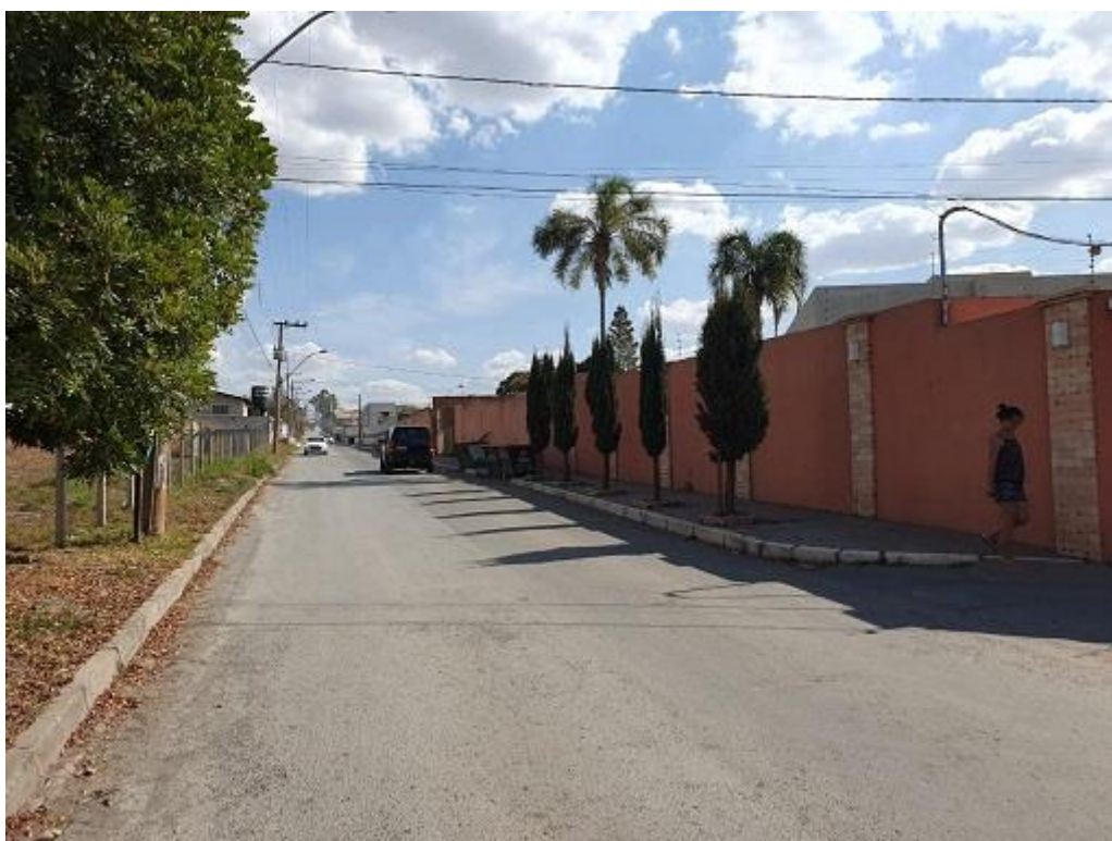
Figura 15 - Muro que confronta área pública
