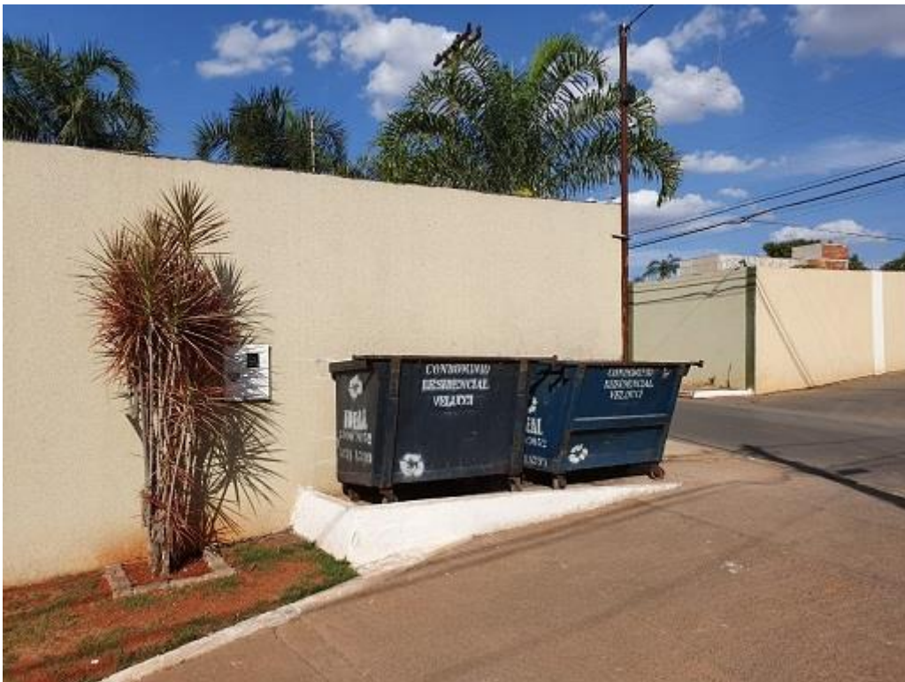
Figura 25 - Muro que confronta área pública
