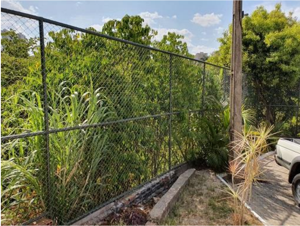
Figura 12 - Fundos do loteamento com alambrado
