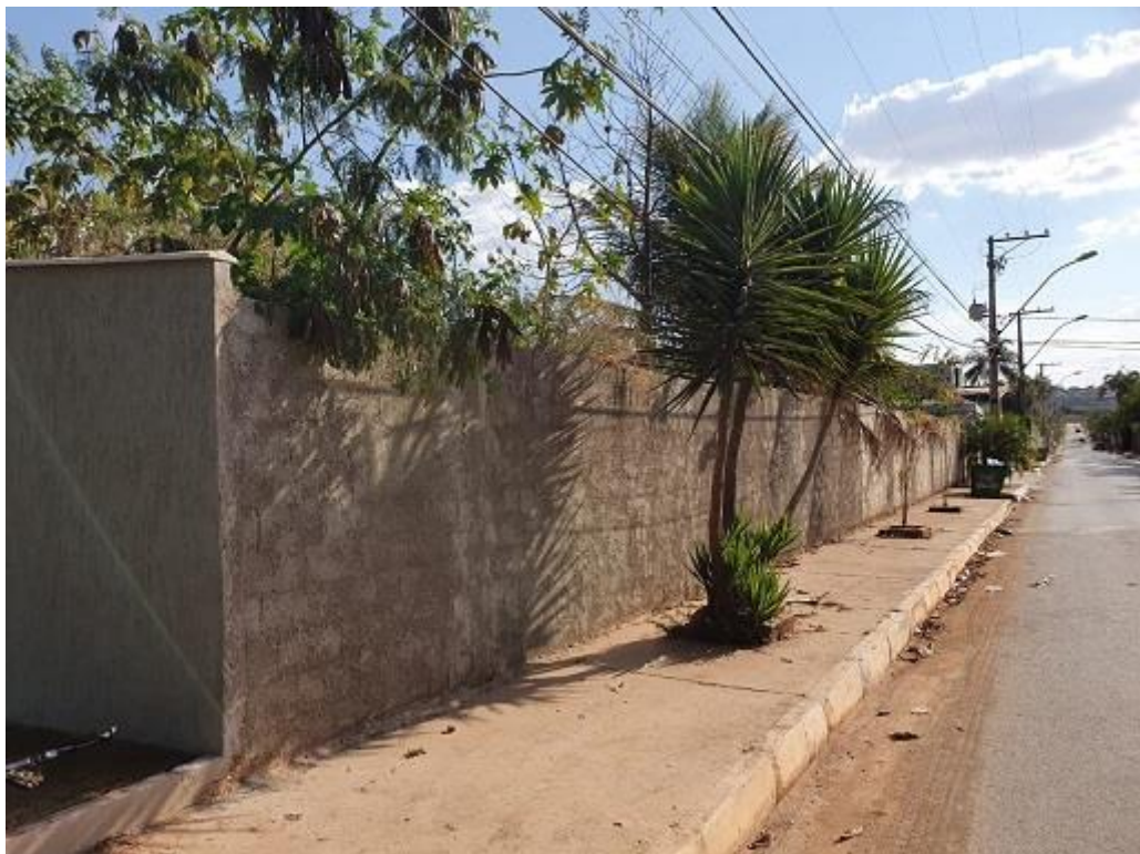
Figura 5 - Muro que confronta área pública
