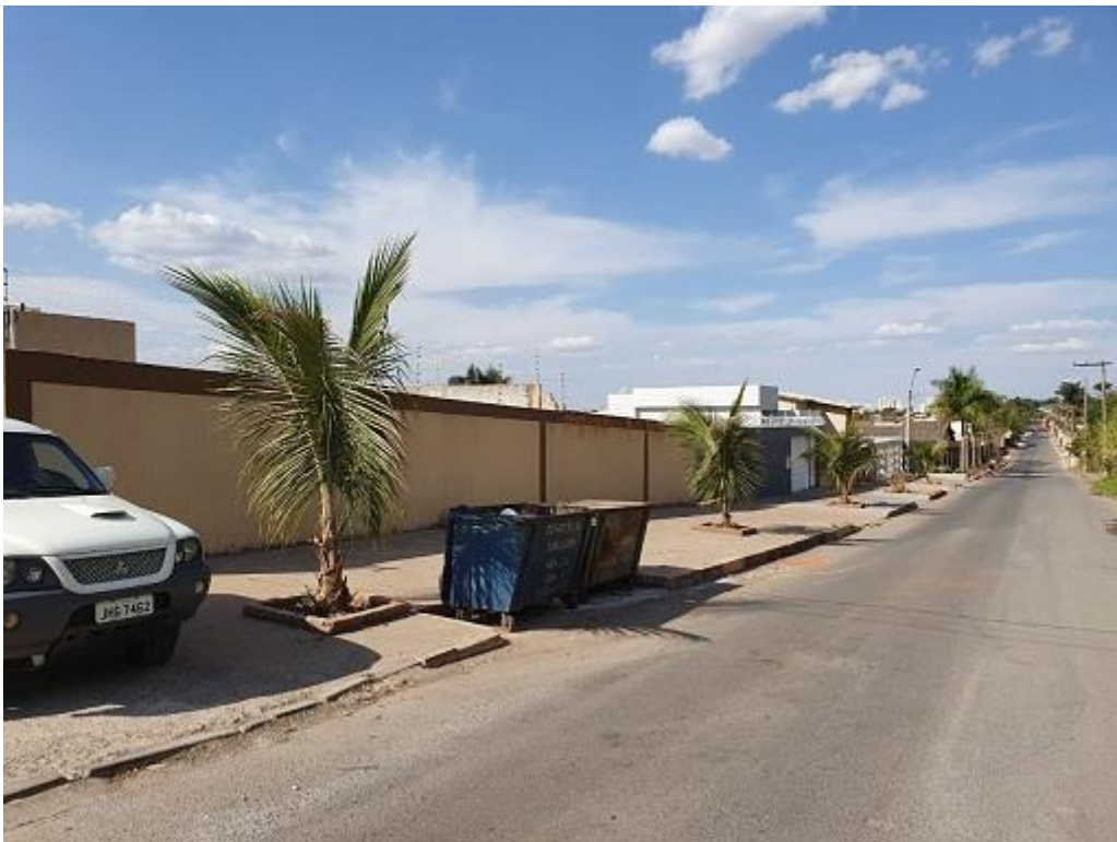
Figura 21 - Muro que confronta área pública
