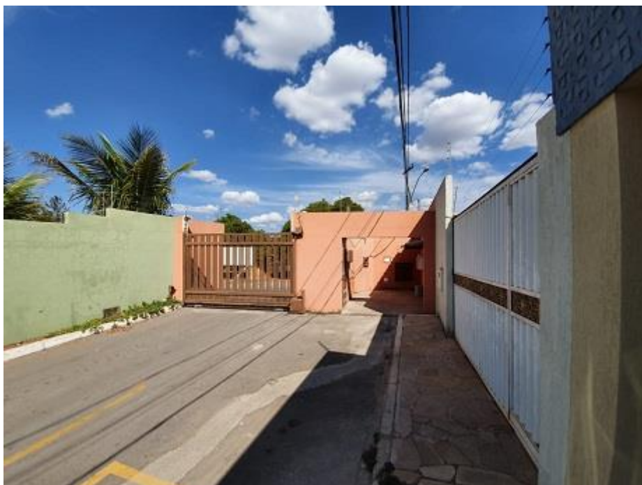
Figura 14 - Portão de entrada s/ guarita
