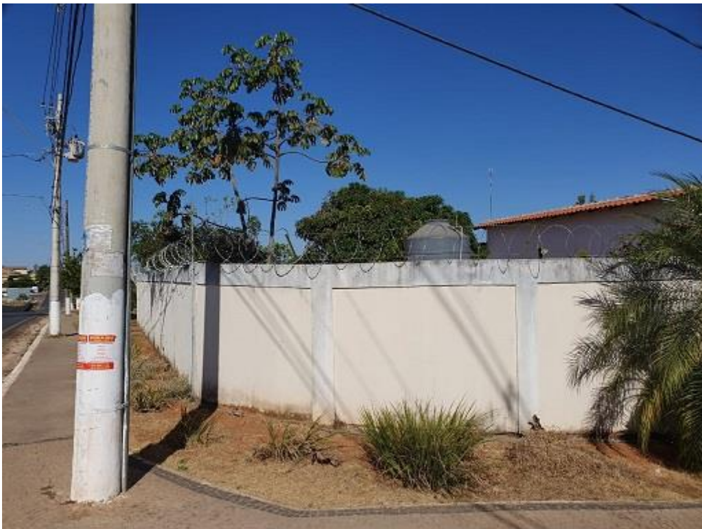
Figura 5 - muros que confrontam área pública
