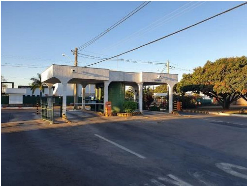
Figura 22 - Entrada secundária com cancelas e guarita
