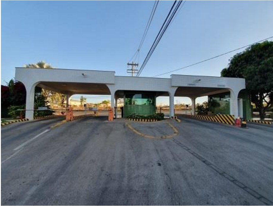
Figura 23 - Entrada principal com cancelas e guarita
