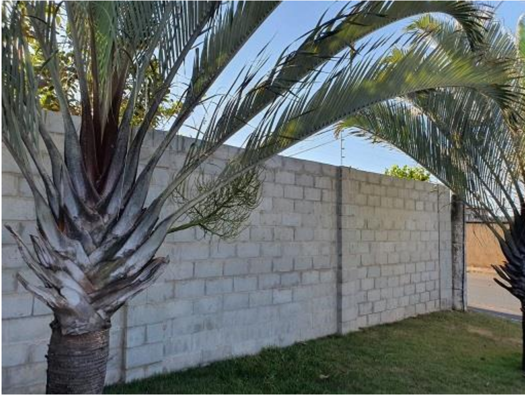
Figura 21 - Muro que confronta área pública
