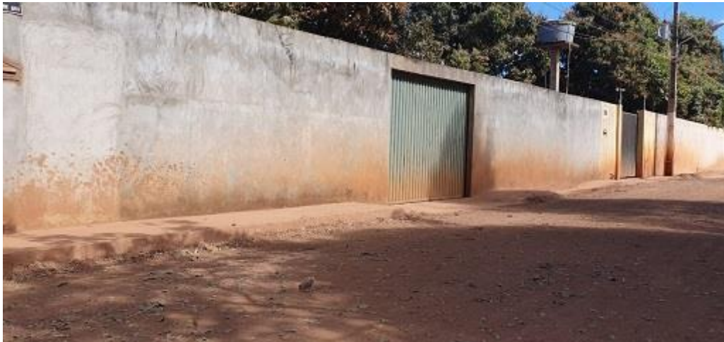
Figura 4 - Muro que confronta área pública
