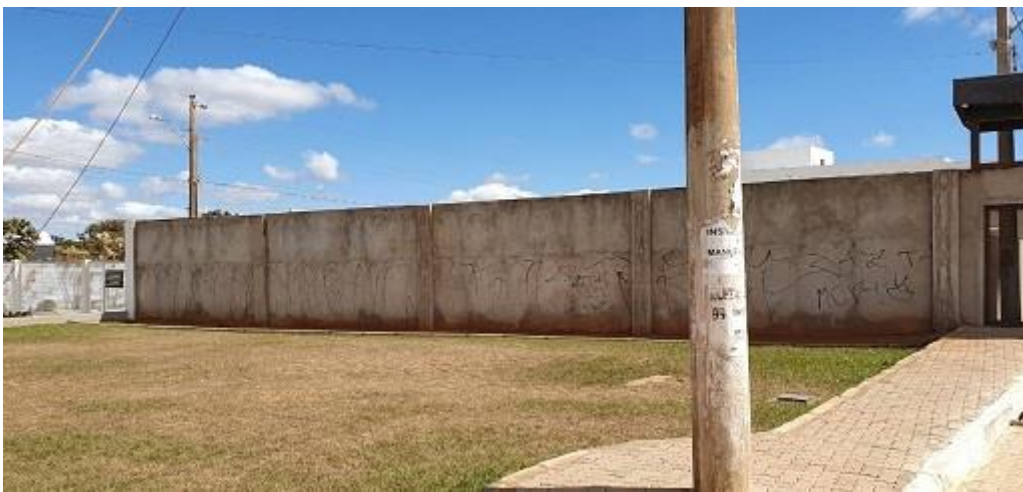
Figura 10 - muro que confronta área pública
