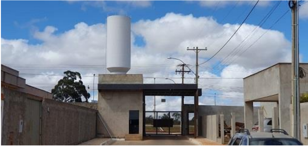
Figura 9 - Vista interna do portão c/ guarita
