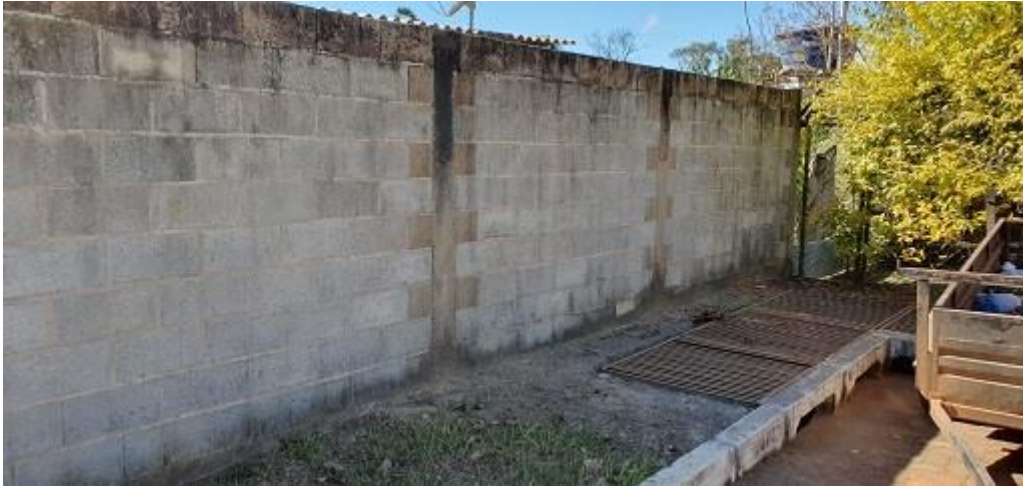
Figura 3 - Muro que confronta área pública
