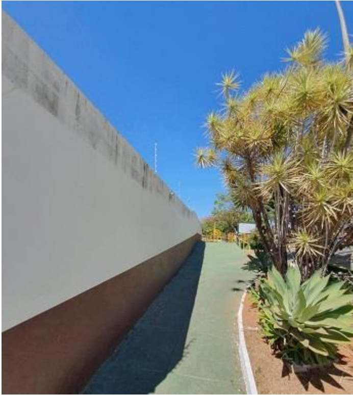
Figura 5 - Muro que confronta área pública
