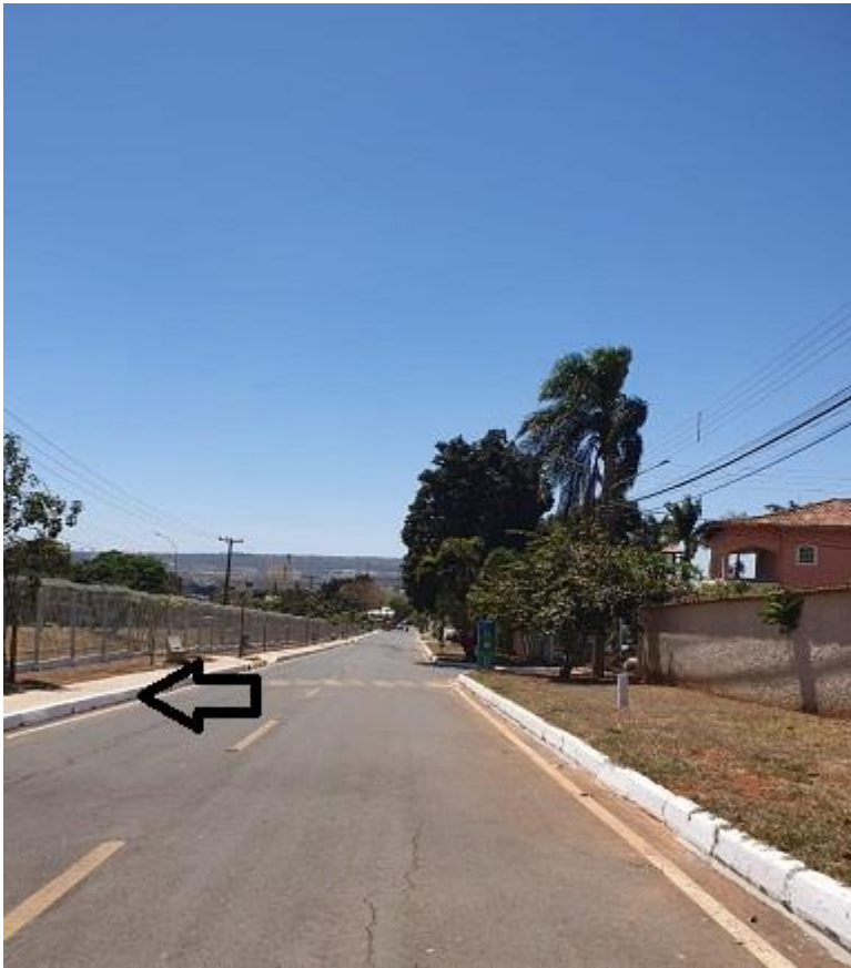
Figura 16 - Alambrado que confronta área pública
