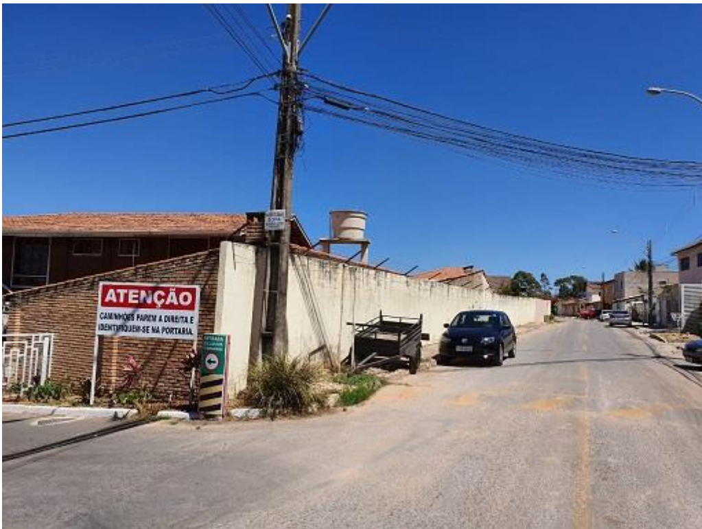
Figura 10 - Muro que confronta área pública
