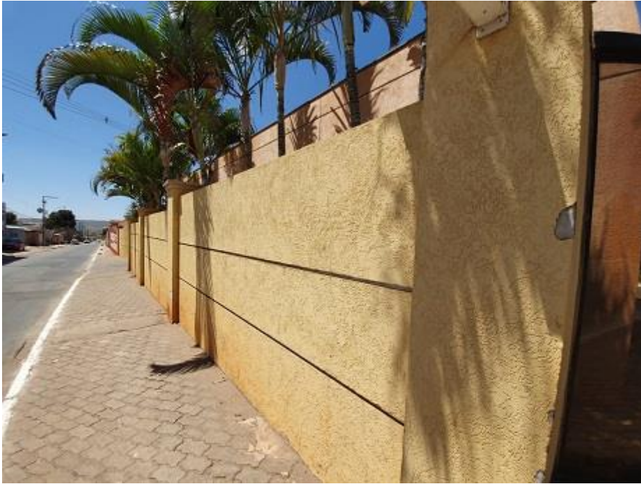
Figura 21 - Muro que confronta área pública
