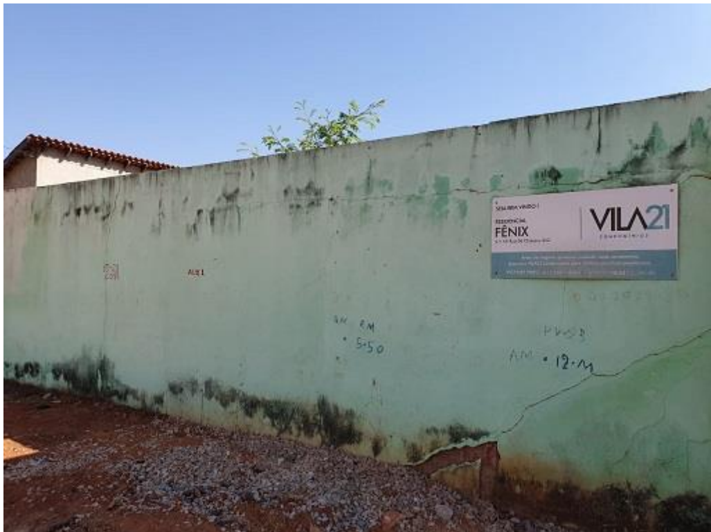
Figura 1 - Muro que confronta área pública
