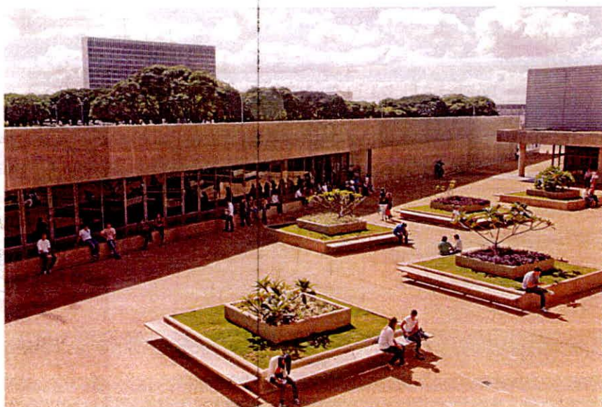
Imagem do Pátio interno do CLDF
