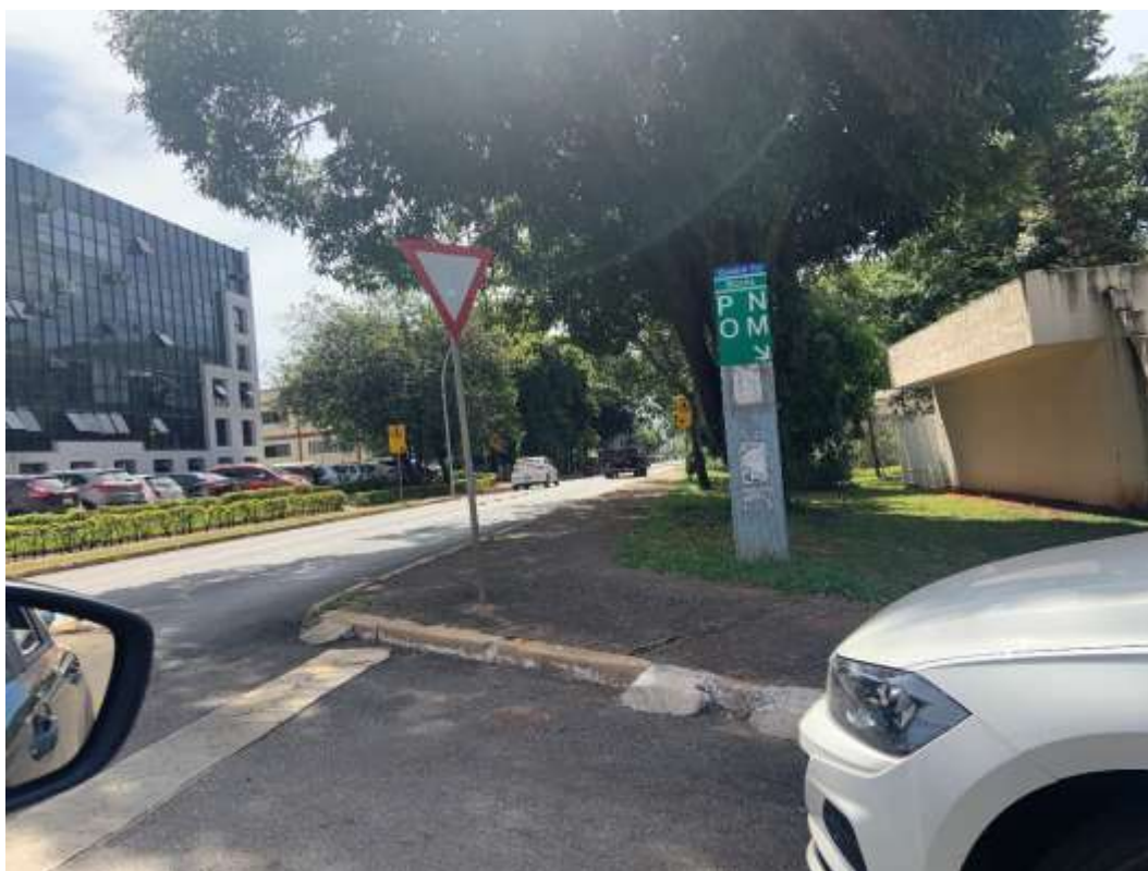
Figura 16: Ausência de rampa no acesso ao passeio na via W4 Sul. Fonte: AGC Projeto e Planejamento.
