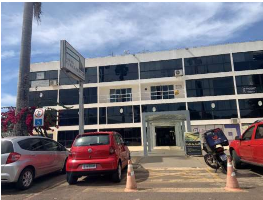
Figura 11: Rampa de acesso na via de acesso aos lotes do SGAS. Fonte: AGC Projeto e Planejamento.
