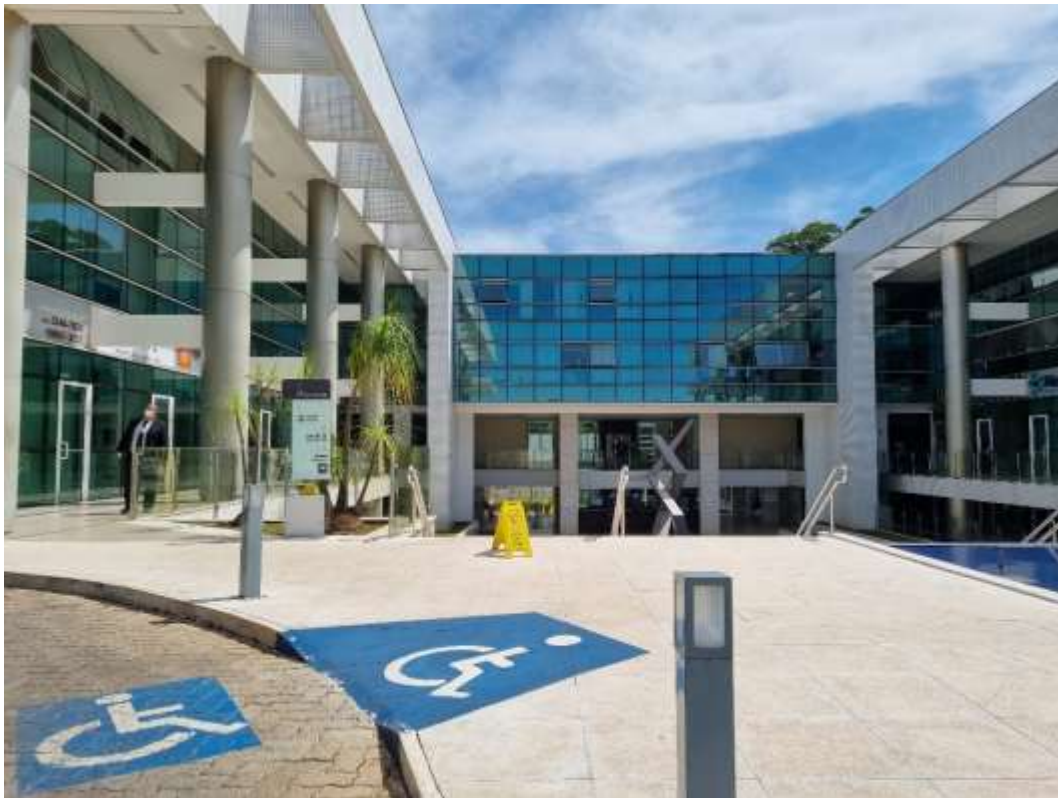
Figura 13: Rampa de acesso na via de acesso aos lotes do SGAS. Fonte: AGC Projeto e Planejamento.
