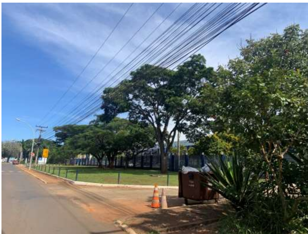
Figura 15: Rampas de acesso à calçada inadequadas na via W5 Sul. Fonte: AGC Projeto e Planejamento.
