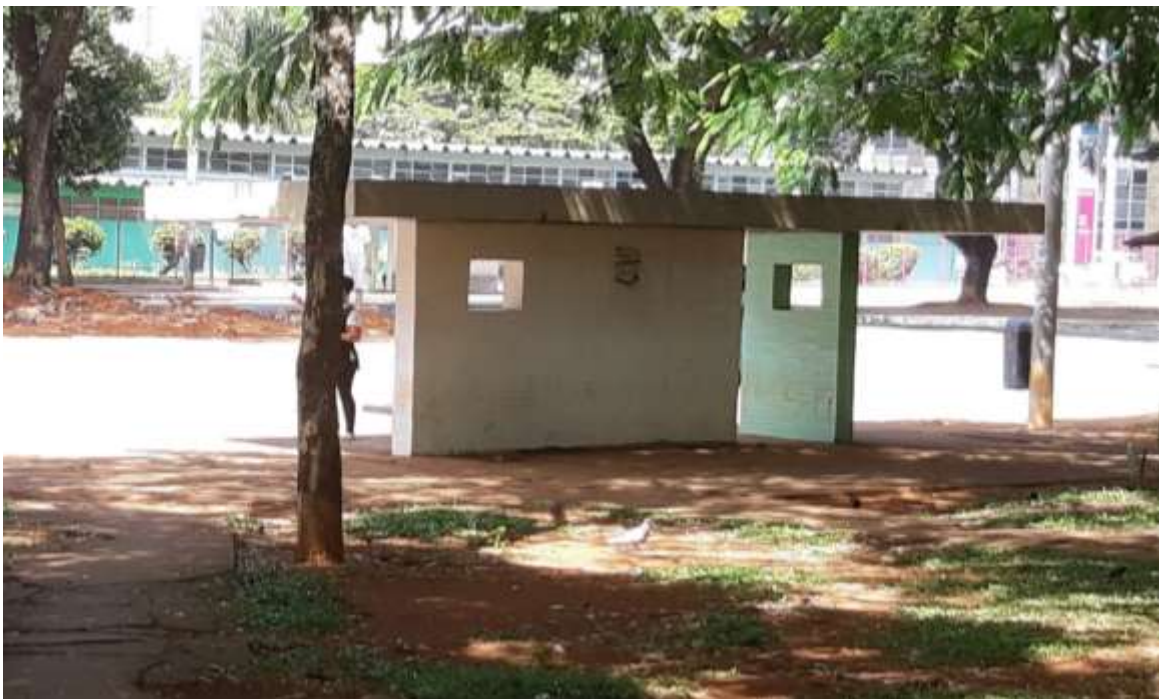
Figura 24: Abrigo padronizado das paradas de ônibus da W3 Sul na AIDT. Fonte: AGC Projeto e Planejamento.
