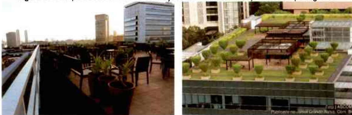
Figura 8. Exemplos de cobertura de edificações com tratamento arquitetônico e paisagístico.
