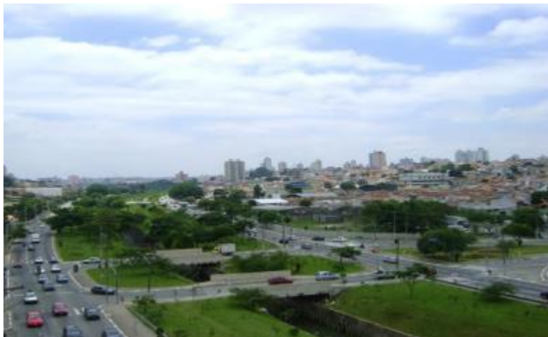
Figura 4 - Canal de Drenagem em Tiquatira-SP
