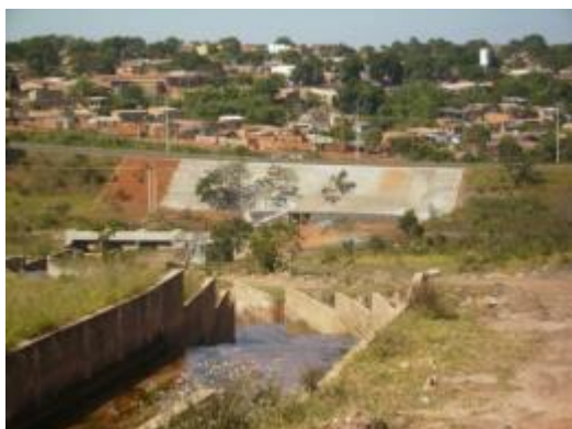
Reforço do talude do bueiro da DF-290 executado pelo DER-DF (05/2008)
