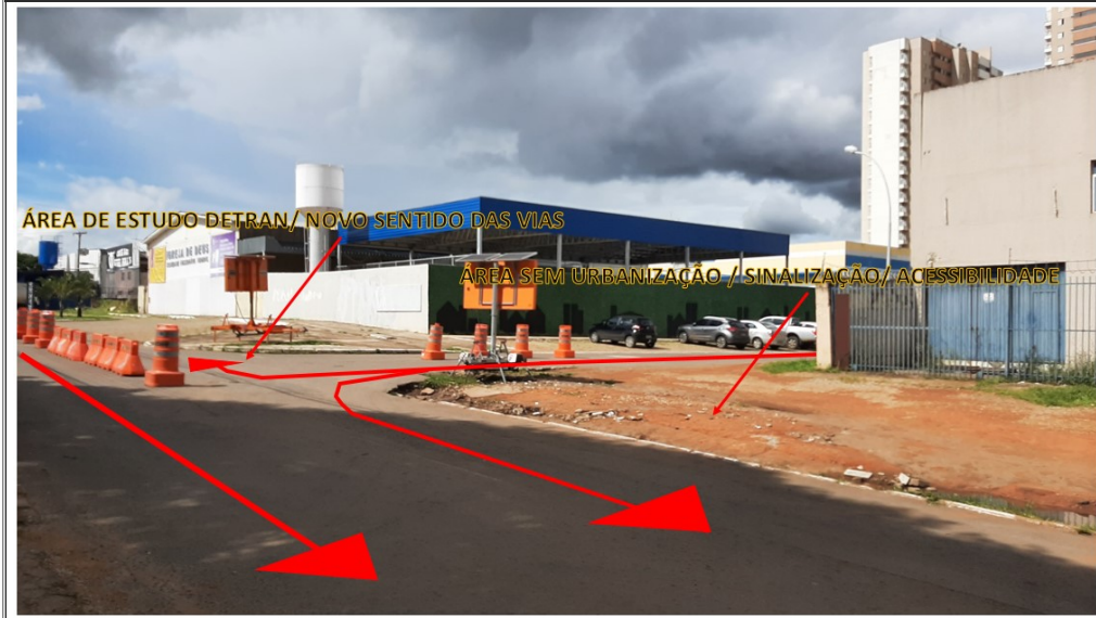
Figura 9 - Sinalização provisória (mudança no sentido da via) - (Foto 1)
