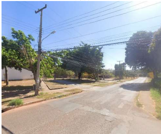
Figura 9: Registros fotográficos realizados no dia 13/11/2024.
