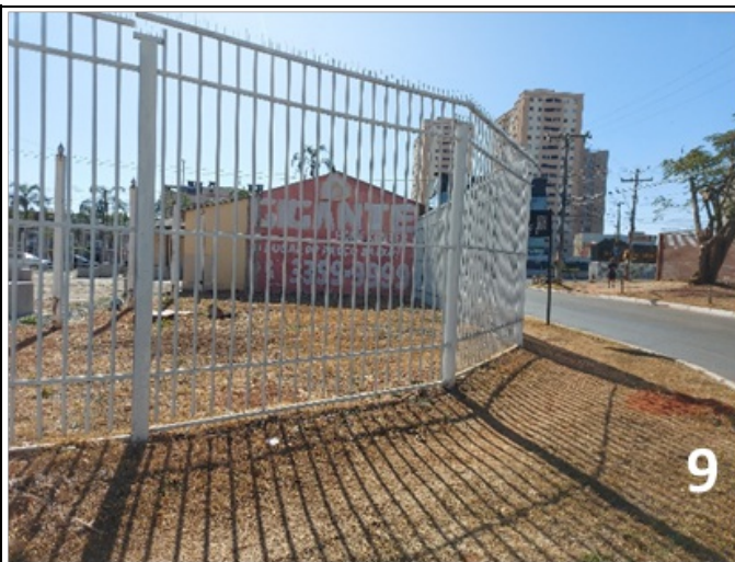
Construção fundos da igreja. Falta de calçada.
