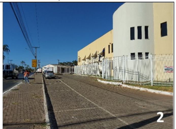
Vista da continuação do estacionamento já implantado na lateral e calçada, paralelos a avenida leste, onde está previsto no projeto original uma ciclovia Foto: Dioest agosto/2022
