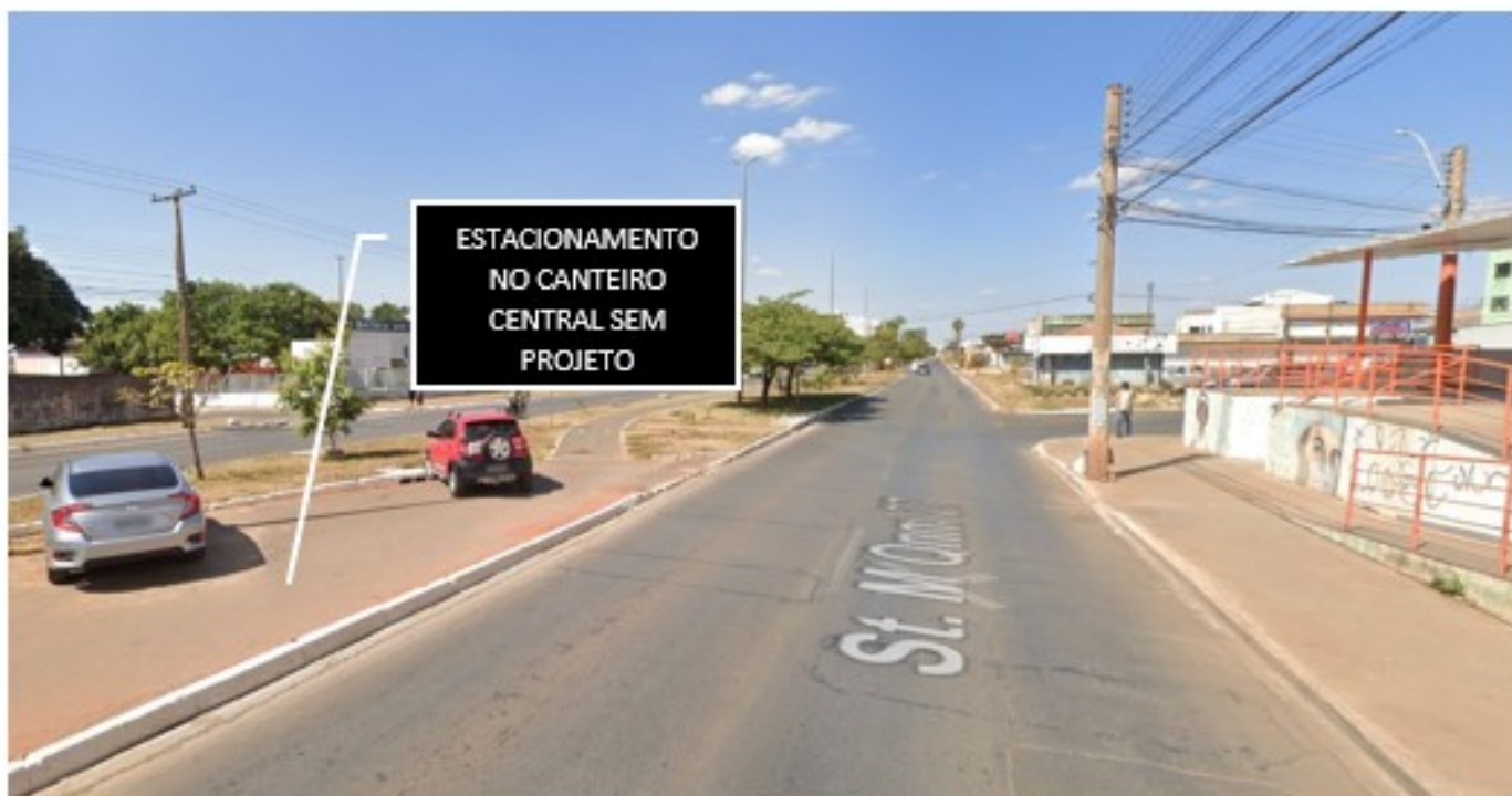
Figura 10- SITUAÇÃO ATUAL DA VIA: FONTE : GOOGLE EARTH.
