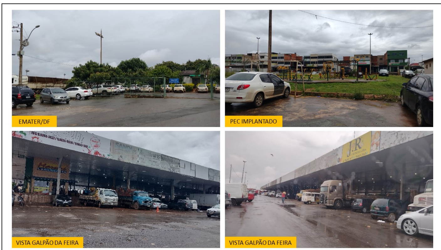
Figura 18: Vista da área – Vistoria 07/02/2022. Fonte: SUDEC/DIOEST.
