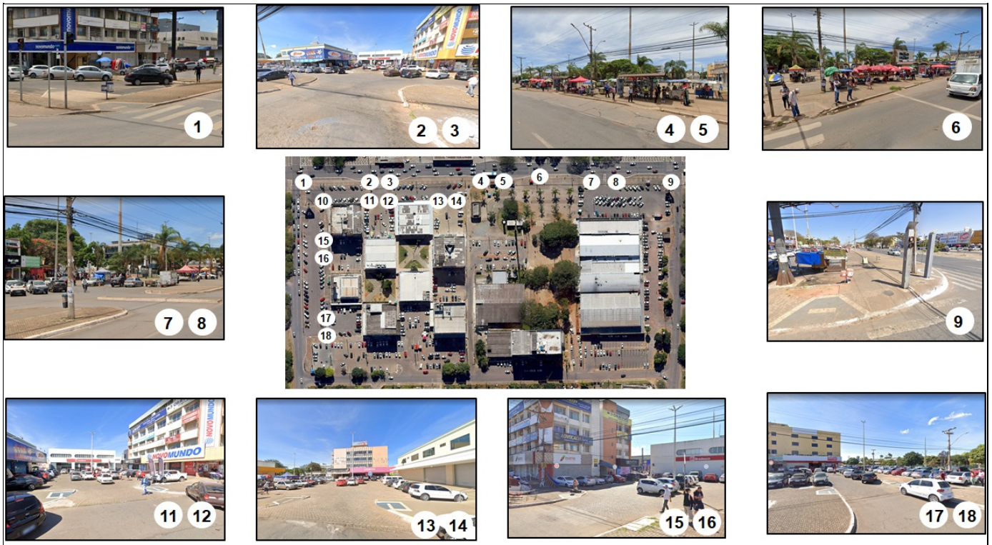
Figura 20: rampas de acesso existentes na área de estudo, montagem DIOEST sobre imagem do Google Street View e vistoria local
