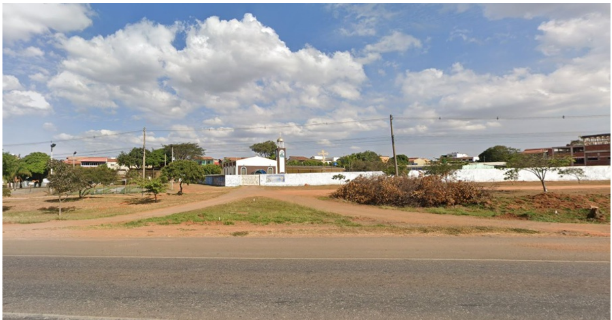
E – Acesso irregular existente asfaltado conectando diretamente o Lote QN 3 AE 2 até a EPNB
