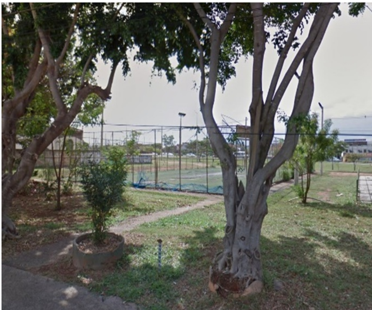
A – Quadra de futebol society em situação de abandono, com alambrado degradado
