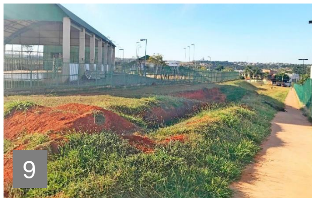
Fig. 9: Barragens Inacabadas para contenção de enxurrada.
