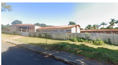
A – Vista frontal da área, com cercamento e portão
