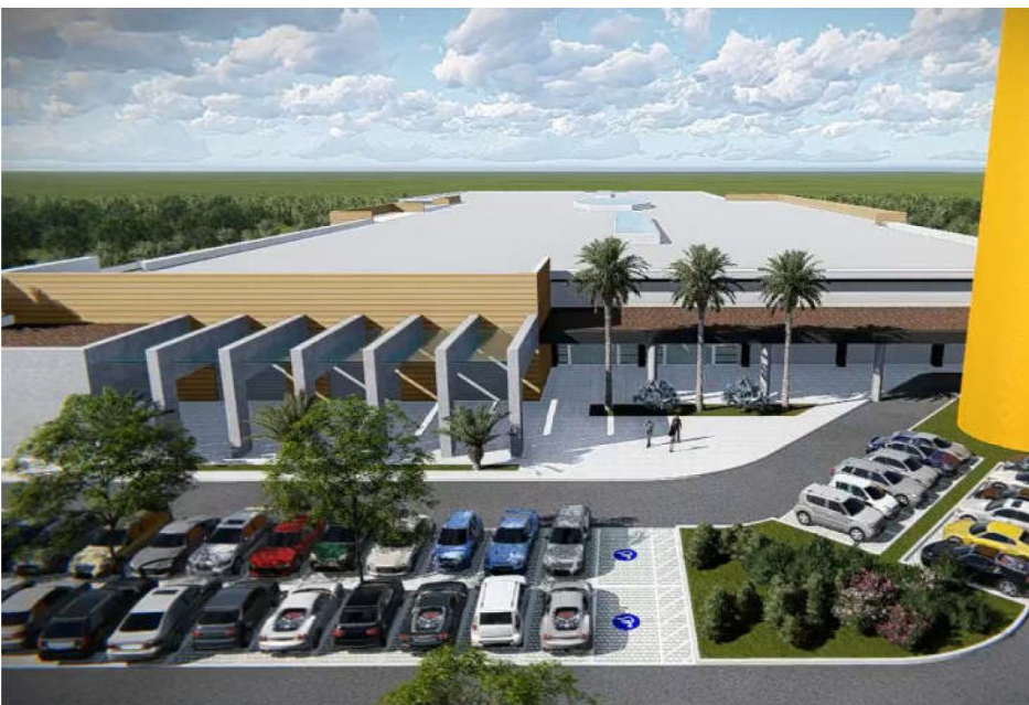
Fig. 03- Fachada do empreendimento voltado para a DF 128 e Setor Habitacional Mestre d’ Armas. Fonte: EIV (44639550).
