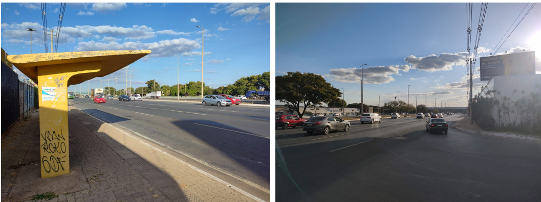
Fig. 03 e 04. Implantação de faixa de aceleração na via EPTG. Fonte. Vistoria realizada em 13/07/2022.
