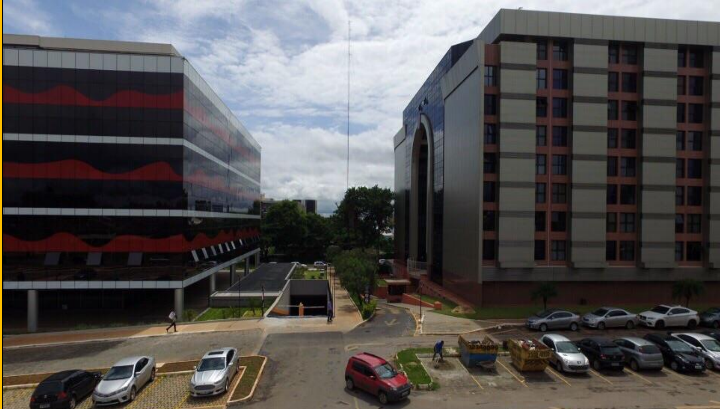
Vista das laterais das edificações dos lotes “D” e “C” .
