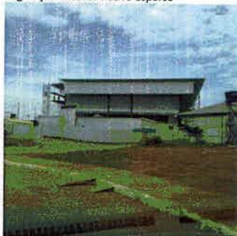
Vista da fachada sudoeste do ginásio
