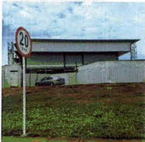
Vista da fachada sudoeste do ginásio
