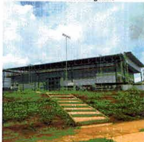
Vista da fachada noroeste do ginásio
