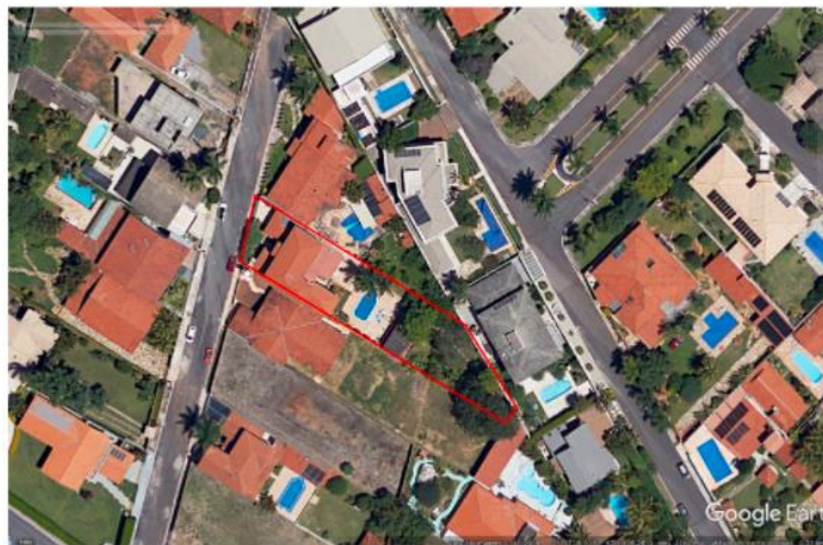
GOOGLE EARTH_ FOTO 01/2018
