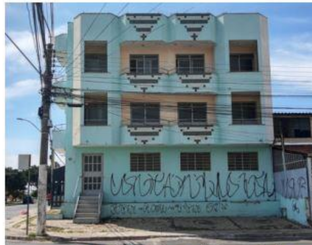
Figura 16: Fachada principal fotografada em vstoria tcnica. Fonte: Vstoria Tcnica de 18/5/2021.
