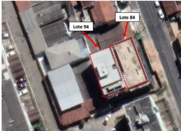
Figura 3: Edificações aparentemente concluídas, apesar dos índices extrapolados e do lote 84 sequer possuir licenciamento. Fonte: Google Earth. Data provável: abril/2022
