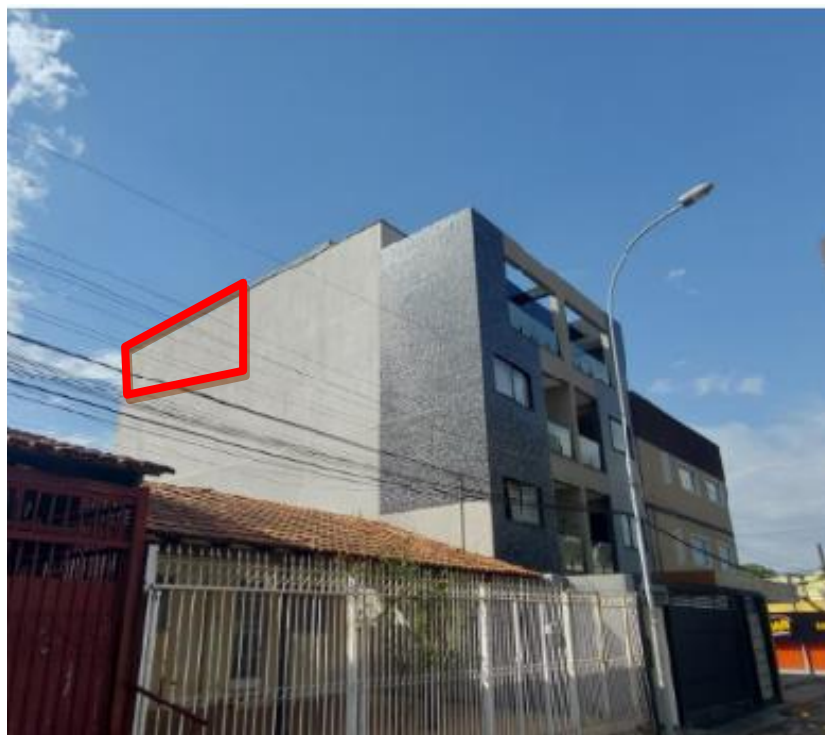
Imagem 4 – área aparentemente coberta no 4º pavimento e não licenciada (em vermelho)
