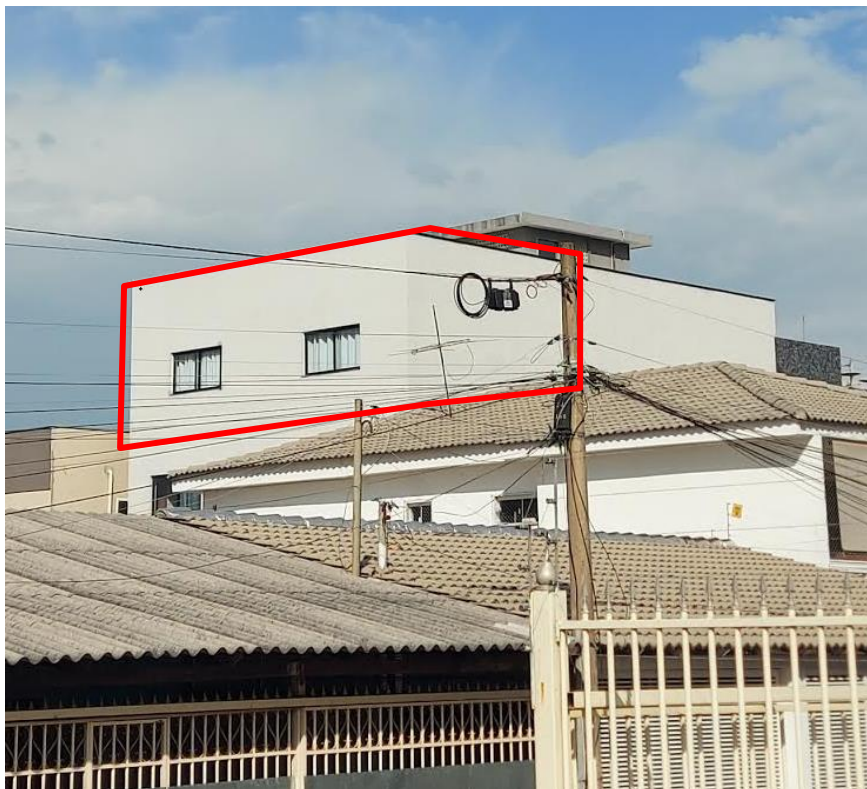
Imagem 7 - Vista do fundo (outro ângulo) da edificação, área coberta no 4º pavimento e não licenciada
