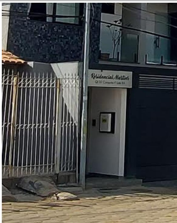
Imagem 2 – Placa de Residencial, entrada lateral de pedestres individualizada e caixas de correspondência cobertas por tampão de madeira c/ fechadura. Foto atual
