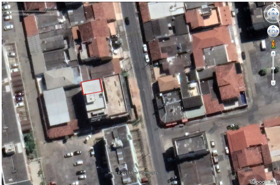
Imagem 5 – Foto de satélite do Google, mostrando área aparentemente coberta no 4º pavimento e não licenciada (em vermelho)
