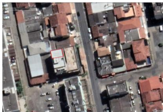
Imagem 5 – Foto de satélite do Google, mostrando área aparentemente coberta no 4º pavimento e não licenciada (em vermelho)
