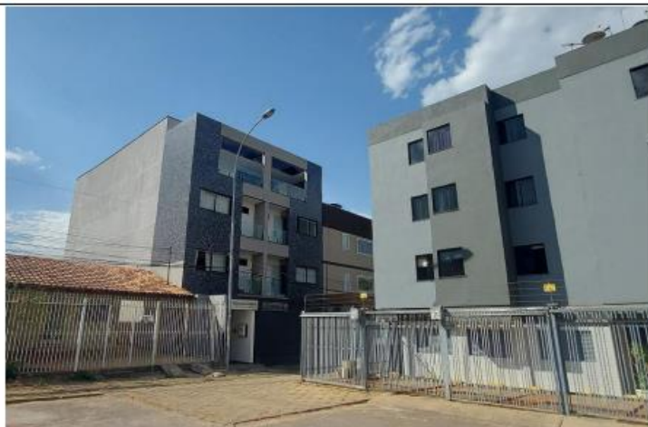
Imagem 1 – frente da edificação com altura final maior que o prédio de habitação coletiva ao lado direito.
