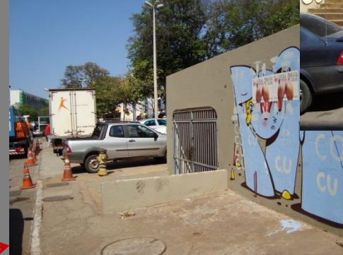
- Demolição de banheiros públicos
