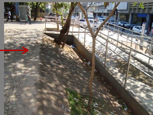
- Adequação de rampa existente
