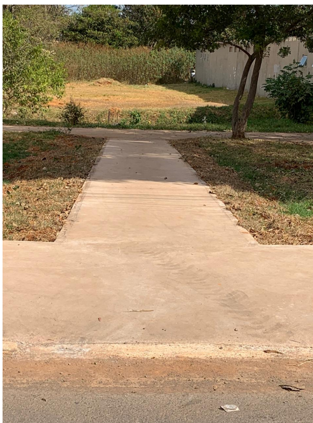
Calçadas executadas nas proximidades do Hospital Regional de Brazlândia
