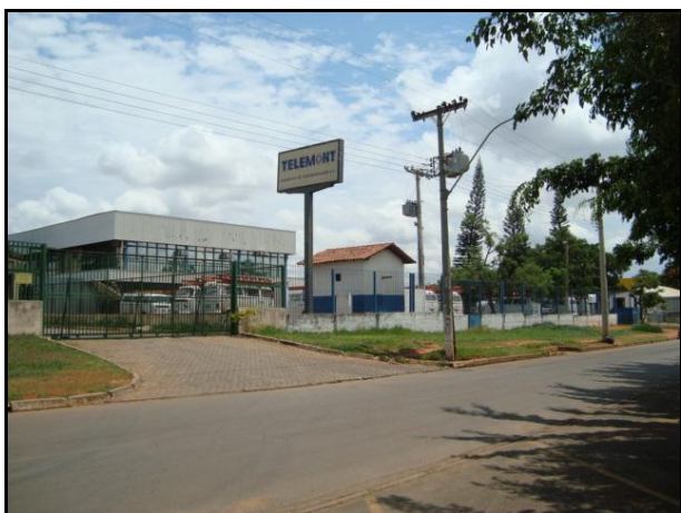
Foto 15: SGCV Lt. 14 – Telemont, lote que já teve a edificação demolida para implantação do Base II.
