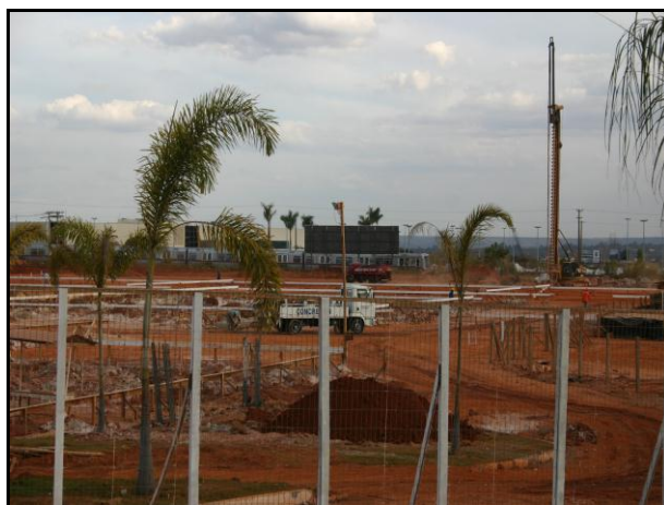
Foto 22: SMAS, Trecho 1, Lote C – obra do Super Quadra Living Park Sul .
