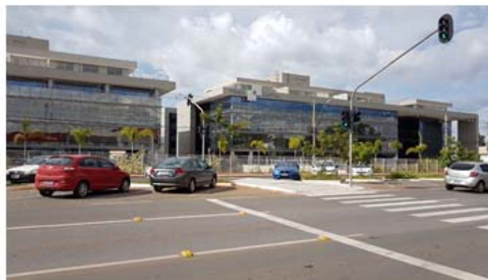
Figura 69: Intervenção viária executada pelo empreendedor.
