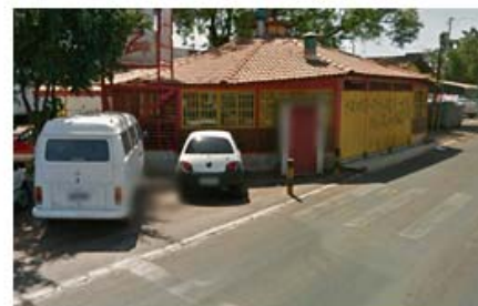
Figura 66: Faixa de pedestres interrompida por estacionamento/canteiro central.
