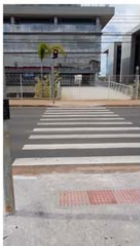
Figura 67: Calçada e faixa de pedestre executada pelo empreendedor
