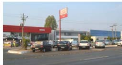
Figura 62: Ausência de calçada no canteiro central.
