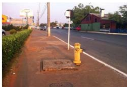
Figura 61: irregularidade na calçada e ausência de sinalização tátil.
