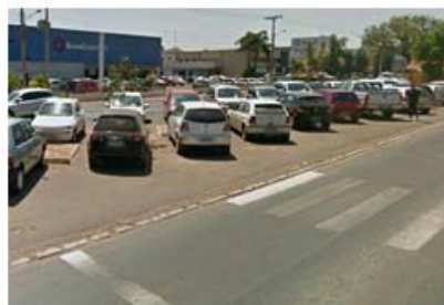
Figura 65: Faixa de pedestres interrompida por estacionamento/canteiro central.
