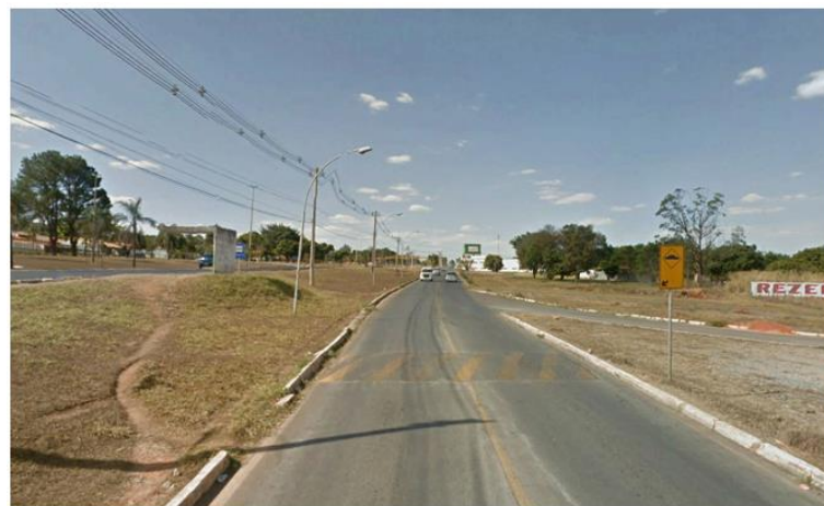
Ausência de calçadas e sinalização de pedestre para paradas de ônibus - Via marginal (Ponto 08)
