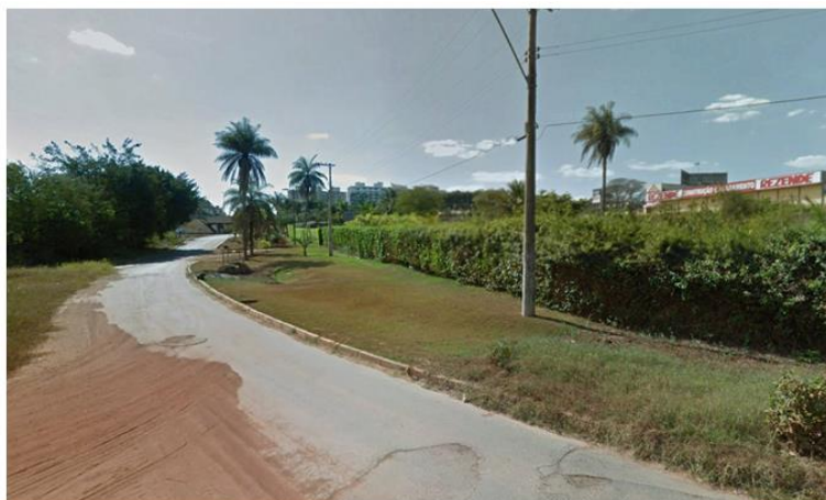
Ausência de calçadas e de drenagem na via lateral ao empreendimento (Ponto 09)
