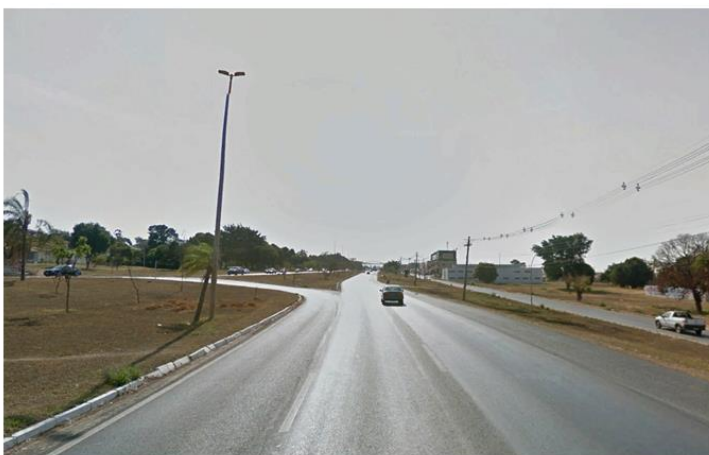
Ausência de calçadas - BR 020 (Ponto 02)
