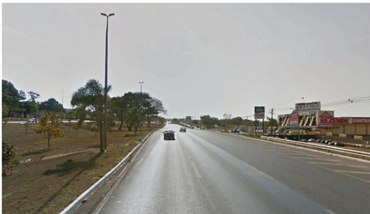
Elevado desnível da BR 020 com empreendimento (Ponto 01)
