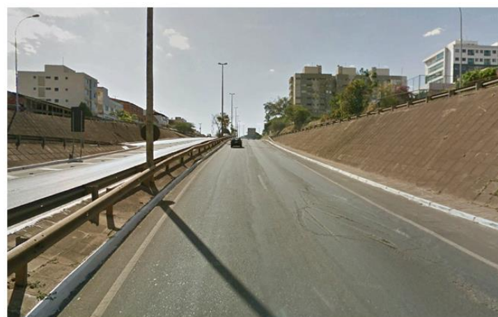
Via entrincheirada - Acesso principal de Sobradinho (Ponto 04)
