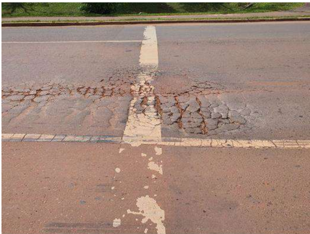
Figura 124 – Estaca 30 do Trecho 03.
