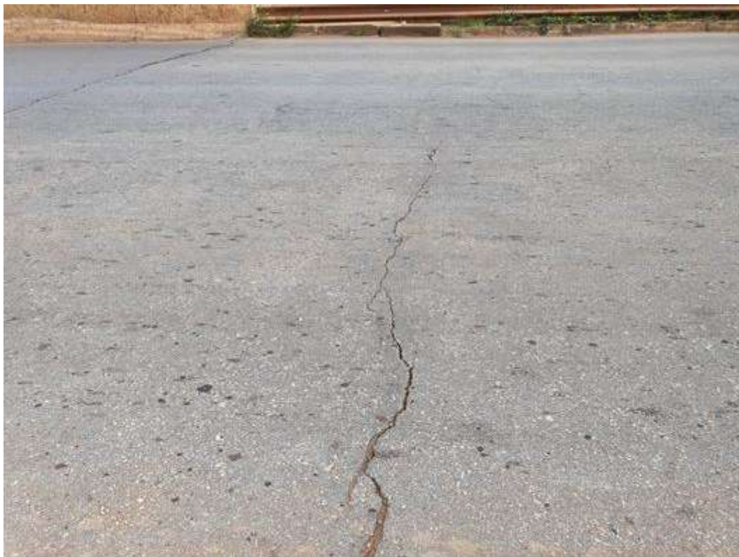
Figura 123 – Estaca 26 do Trecho 02.
