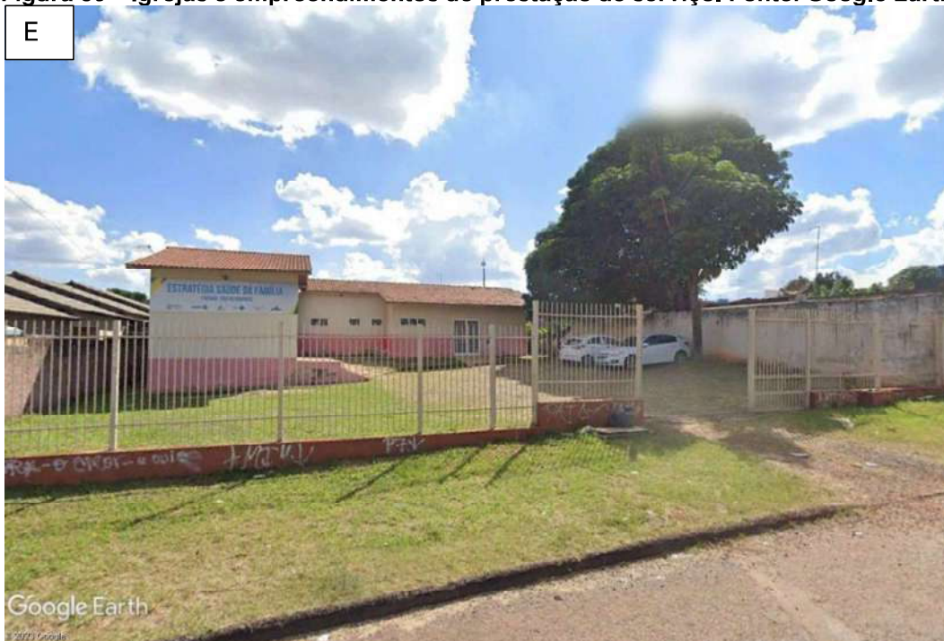
Figura 90 – Unidade de Saúde no meio das casas, em Valparaíso de Goiás. Fonte: Google Earth.
