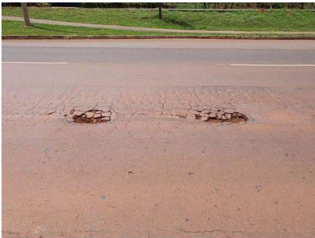
Figura 125 – Estaca 34 do Trecho 03.
