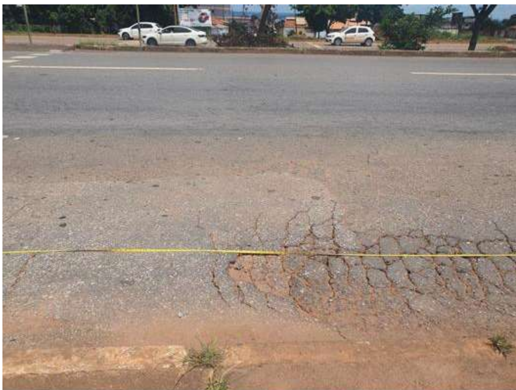
Figura 122 – Estaca 09 do Trecho 02. Fonte: Levantamento Fotográfico.
