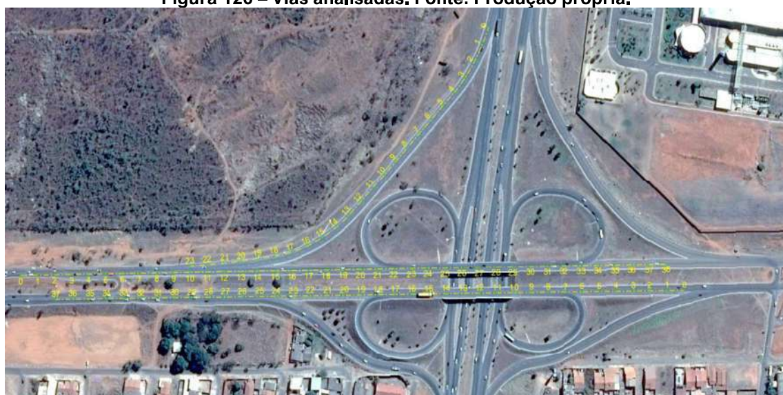
Figura 121 – Estacas dos trechos (20m – 20m). Fonte: Produção própria.
