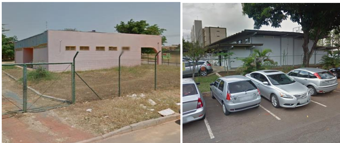
Figura 42. Relação de edifícios de equipamentos públicos com o espaço público. Esquerda: Unidade Básica de Saúde (UBS) Areal, Arniqueiras. Direita: Centro de Saúde (CS) 09, Cruzeiro.
