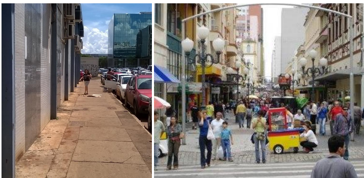
Figura 40. Esquerda: Fachada inativa (nenhuma porta abrindo para o espaço público) no SRTVS, Brasília. Direita: Fachada ativa, Florianópolis.
