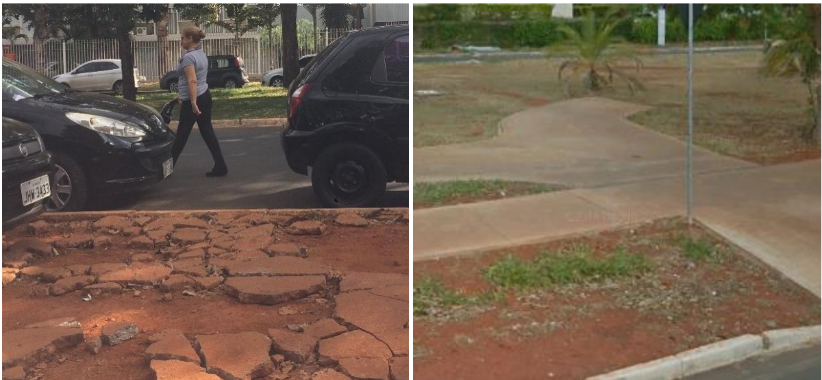
Figura 39. Esquerda: calçada em péssimo estado de conservação no SRTVS, Brasília. Direita: ciclovia interrompida, sem conexão, Sudoeste.
