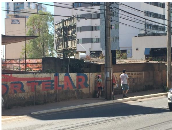
Fig. 19 e 20 - Apropriação de área pública para obra abandonada, deixando a calçada permanentemente não satisfatória.
