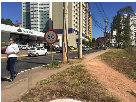
Fig. 14 e 15 - Calçada não satisfatória (dimensão inferior ao definido por norma). No segundo caso, há um uso indevido de parte do espaço público.
