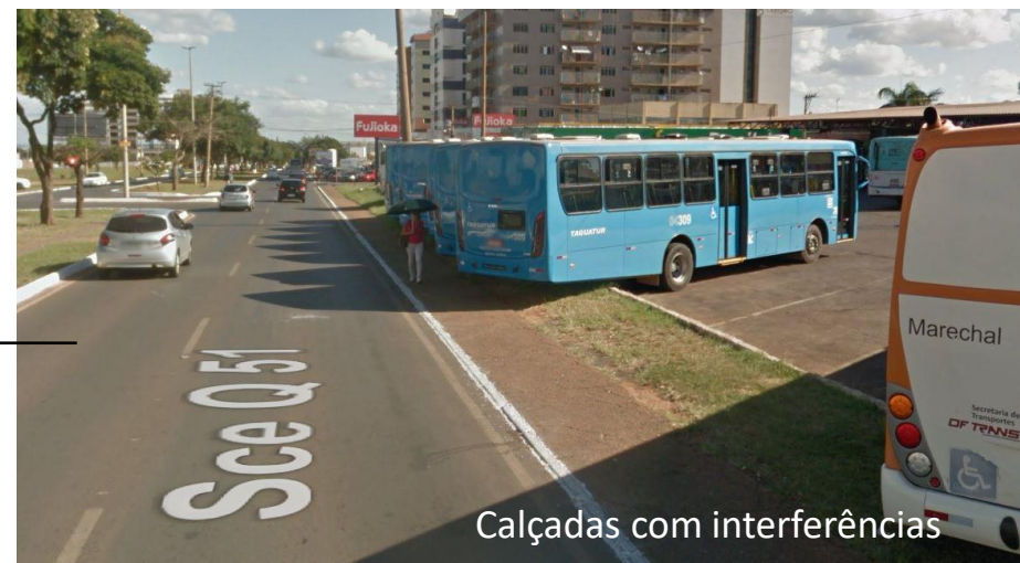
Falta de acessibilidade local
