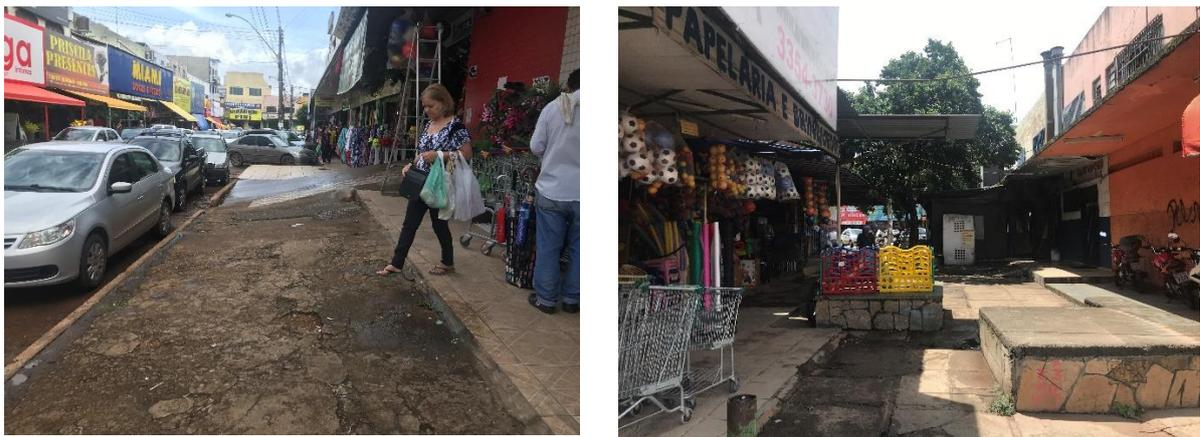
Figura 08 – Áreas de calçadas com desníveis e obstáculos (Fonte: COPROJ)
